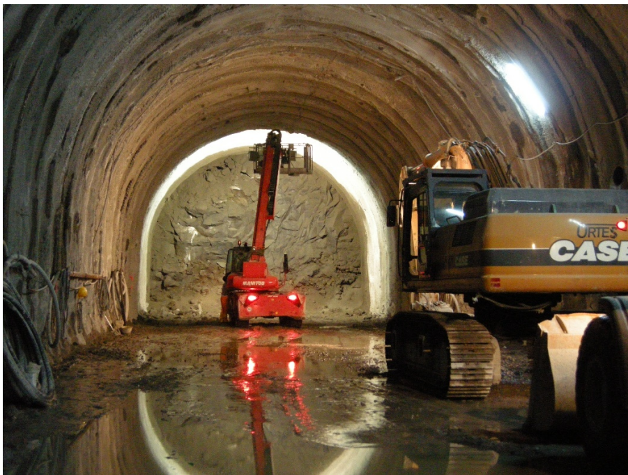
Figura 3 e 4 - Momenti dei lavori
