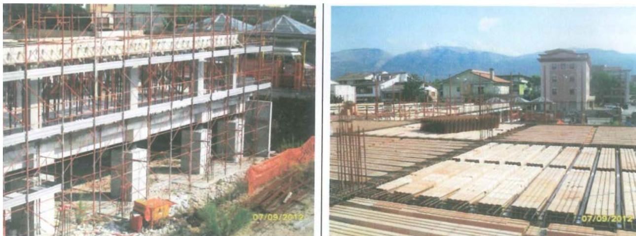
Figura 1 - Le fondazioni dell'edificio scolastico sono su pali con interposti isolatori sismici in modo da rendere la struttura indipendente dalle fondazioni. Fonte: Relazione tecnica descrittiva - Progetto esecutivo.
