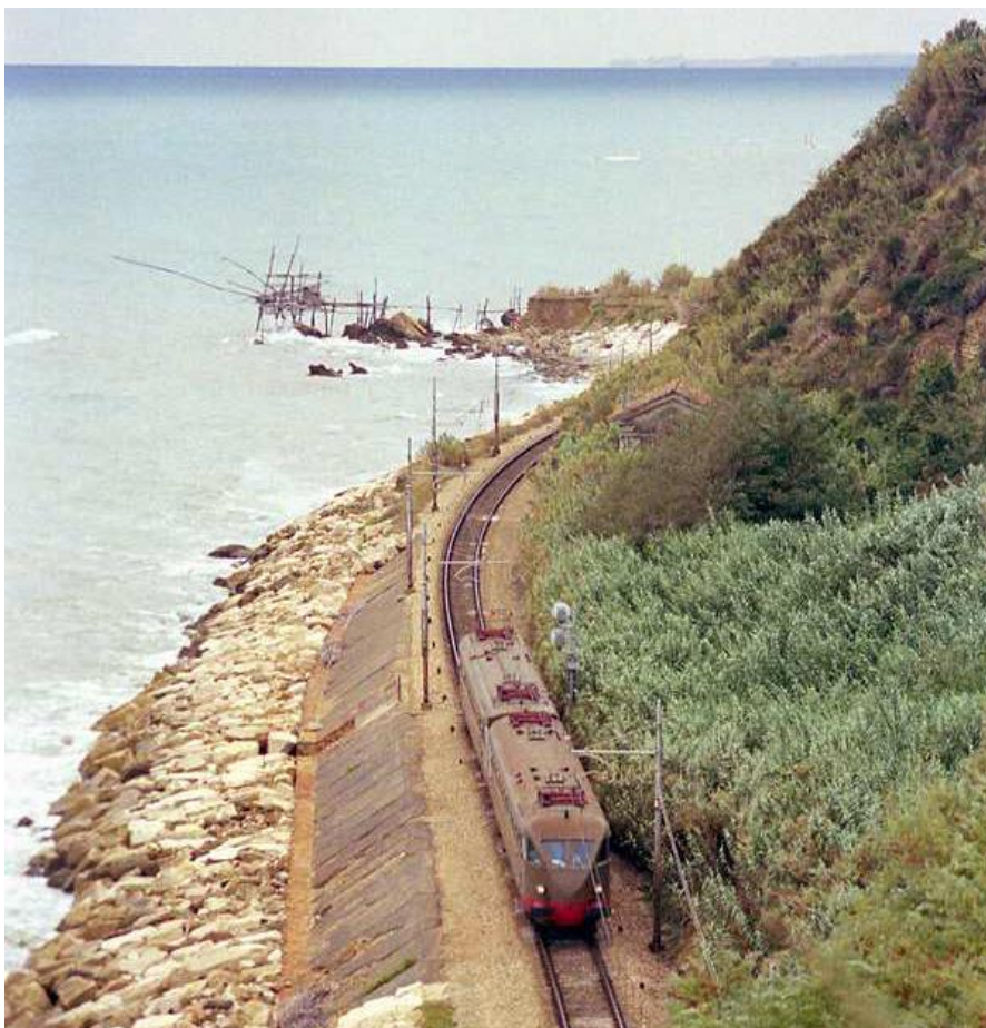
Figura 2 – La vecchia linea ferroviaria
